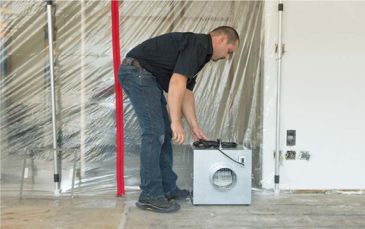
ToolPower Staubfänger – Luftreiniger aufstellen, Magnetrahmen anbringen und einschalten
